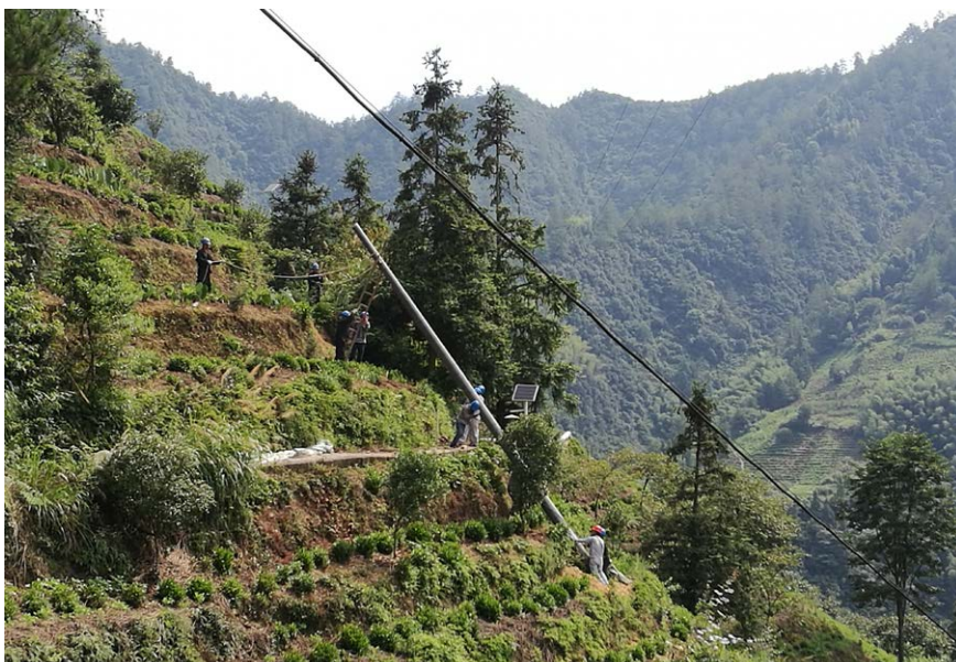
複合材料電線桿幫助安徽黃山地區的電力搶修時間大幅縮短，圖為幾名電力施工人員正在運輸新型電線桿。
