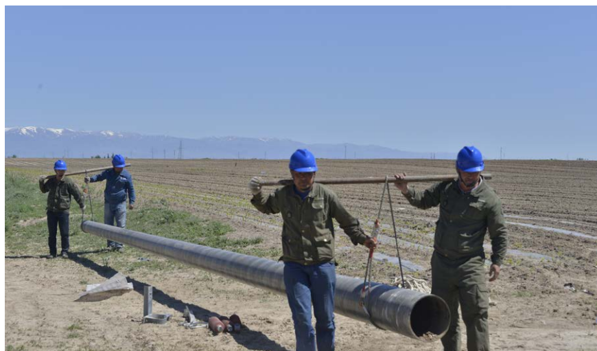
複合材料電線桿重量僅為傳統電線桿的 1/6，大幅節省人力。
